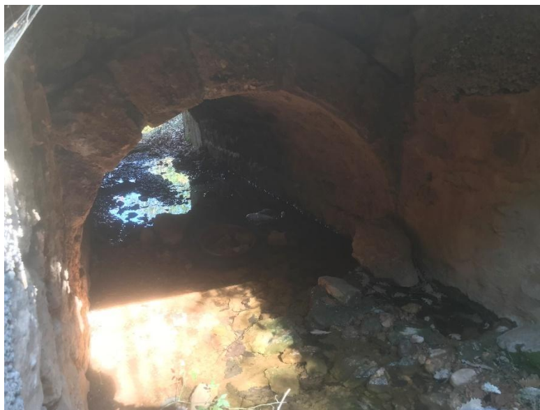
Voûte maçonnée qui franchit la rue de la voie ferrée
